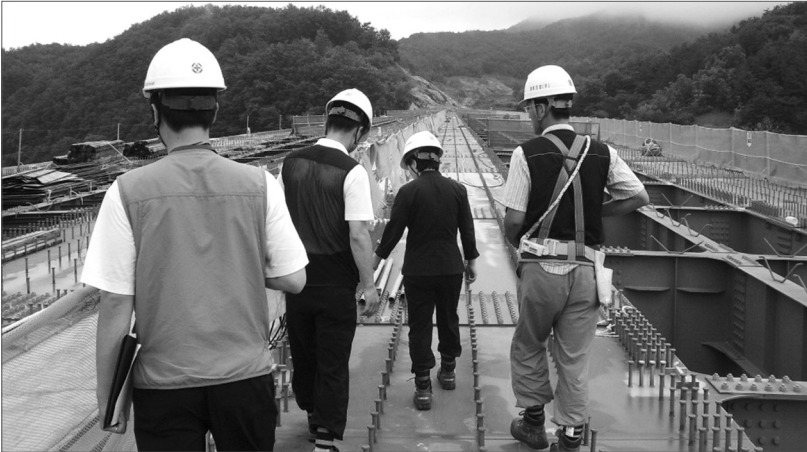
교량 건설현장의 스틸박스 거더 위에서 안전상태를 점검하는 모습
