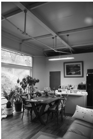
연구를 통해 실현했던 인장구조를 활용한 들림형 보구조 가설건축물과 막구조 캐노피
