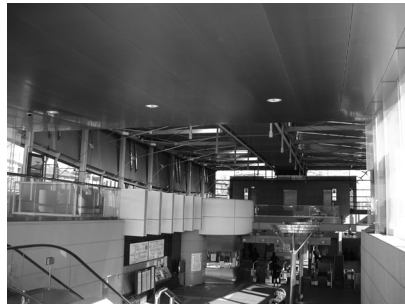
니혼대학 후나바시 캠퍼스 지하철역사 내가 사이토마사오교수를 만날 수 있는 계기가 되었던 작품. 인장구조시스템을 이용해 구조체를 경량으로 만들고 개방적인 인상의 내부공간을 만들었다. 일본건축학회 수상작품.
