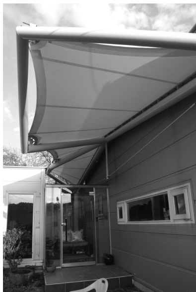
연구를 통해 실현했던 인장구조를 활용한 들림형 보구조 가설건축물과 막구조 캐노피
